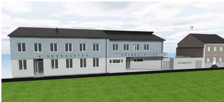
Symbolfoto Kindergarten-Krabbelstube nach Umbau
