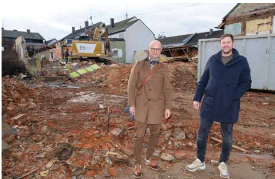
ÖVP-Bürgermeister Markus Hansbauer und Bauausschuss-Obmann, ÖVP-Gemeinderat Lukas Sumereder, informieren sich vor Ort über den Fortschritt der Abrissarbeiten am alten Gasthaus Gintenreiter.
