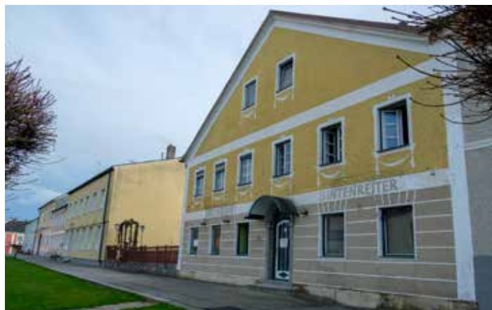
Das alte Gasthaus Gintenreiter am Marktplatz weicht der Kindergartenerweiterung und Krabelstube.
